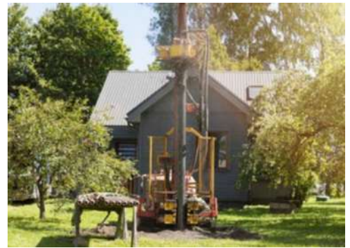
Мал. 9.9 Артезіанські свердловини у землі бурять спеціальними пристроями до глибини 100–1000 м, залежно від розташування водоносного шару
