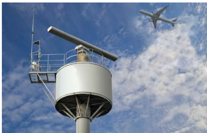
Мал. 36.1. Радіолокаційна станція «спостерегає» за літаками в повітряному просторі
