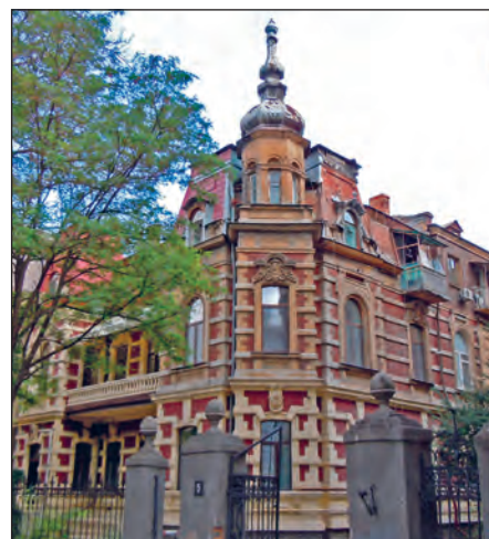
Будинок Ф. Фальц-Фейна в Одесі. Сучасний вигляд
