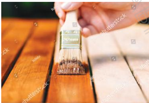
Мал. 4.11. Для підвищення зносостійкості деревину обробляють спеціальними захисними матеріалами
